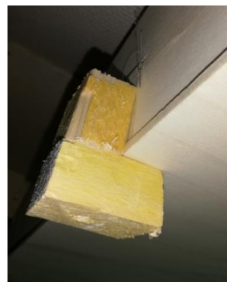
Figure 14 - Système de fixation entre les murs et la piste.
