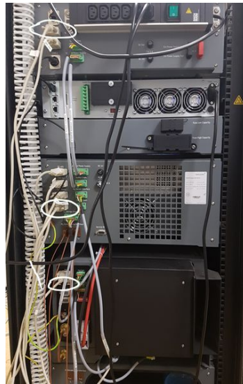
Figure 5. Ports de communication du bus CAN à l'arrière de la PAC
